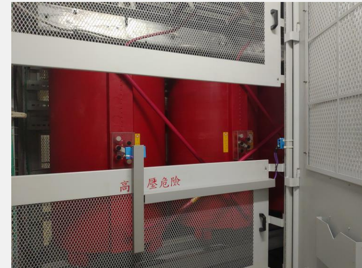
現場實際安裝照片
